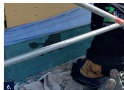
6. Hmotu RD 2 celoplošně nanést na proschlou uzavírající vrstvu pomocí zubové stěrky.
