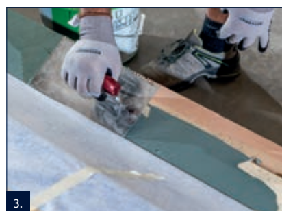
3. Překlopit izolační pásku PB a provést uzavírající vrstvu hmotou RD 2.
