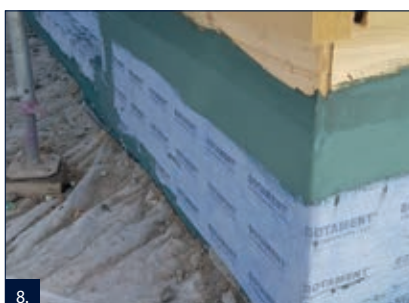
8. Okraje a přesahy izolačního pásu překrýt hmotou RD 2.
