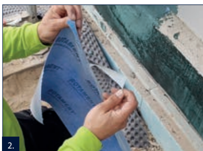
2. Sejmout krycí pásku z lepicího proužku na rubu izolačního pásu.
