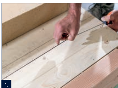
1. Vyměření a označení výšky hydroizolace.
