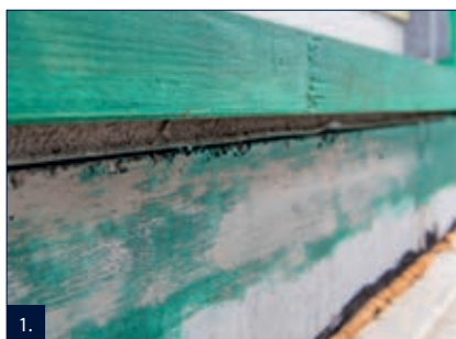
1. Na podkladní ploše vytvořit uzavírající, kontaktní vrstvu produktů RD 1 nebo RD 2.
