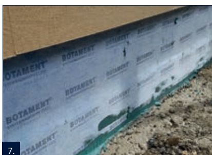
7. Izolační pásku uložit bez zvrásnění.
