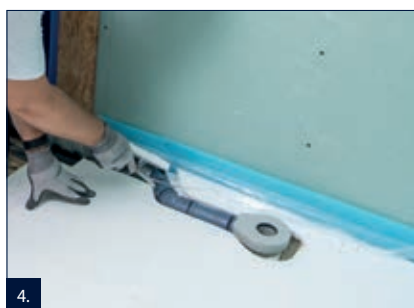
4. Na úroveň instalace uložit izolaci kročejového hluku.
