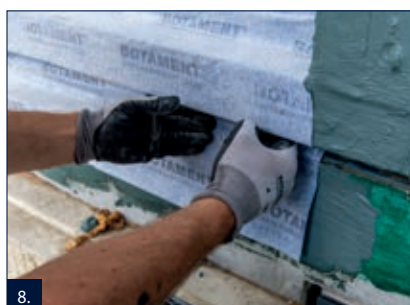
8. Pásku PB uložit bez bublin, či vrásek do čerstvé vrstvy RD 2. V místech, kde se předpokládá větší pohyb, částečně vnořit pásku PB do spáry a tím snížit lokální pnutí.
